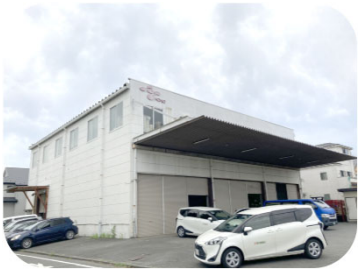
東大和市新堀倉庫
