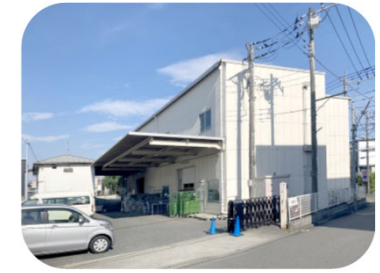
東大和市立野 2丁目倉庫
