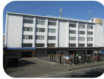
東大和市立野 4丁目倉庫
