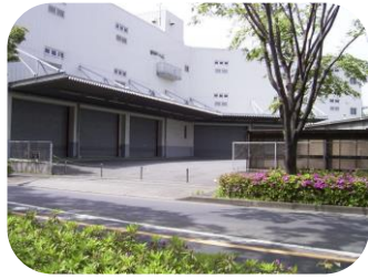
青梅市新町倉庫
